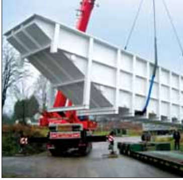
Katodik daldırma boyası havuzu
