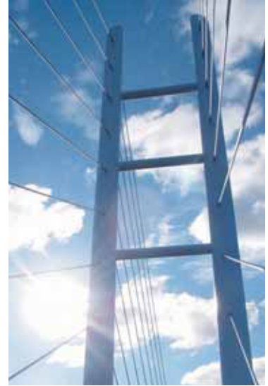
SIMONA® Boruları ile köprülerde eğik çelik halat mantolaması
